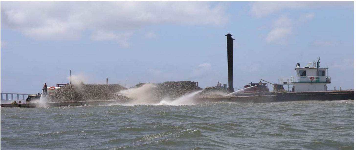
Trông Bãi Vỏ Hàu với Súng Phun Nước để Dễ Dàng Rải Vật Liệu Bãi Vỏ Hàu
